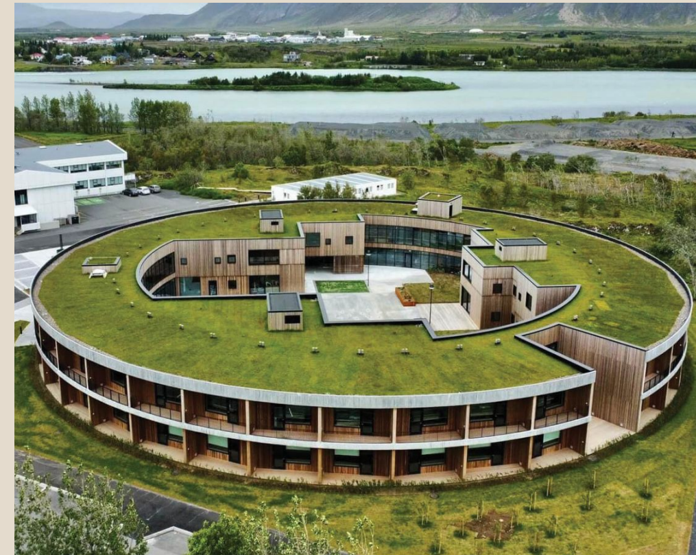
Hjúkrunarheimilið Móberg í Árborg. Mynd: Urban arkitektar og loop architects
